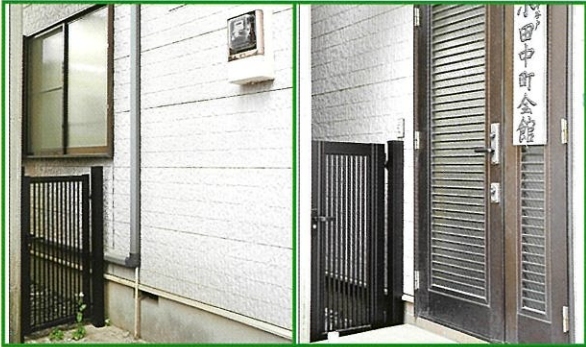
小田中町会館の正面玄関と左脇に、不法投棄防止のために取り付けられた門扉
